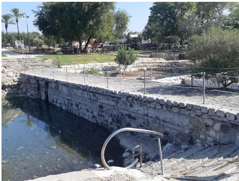
איור 8: גשר הבזלת שנבנה בשנת 1959, עם חנוכת הגן הלאומי. משמש גם כסכר במורד/ במזרח הברכה האמצעית. (צילום: דרור סגל).
