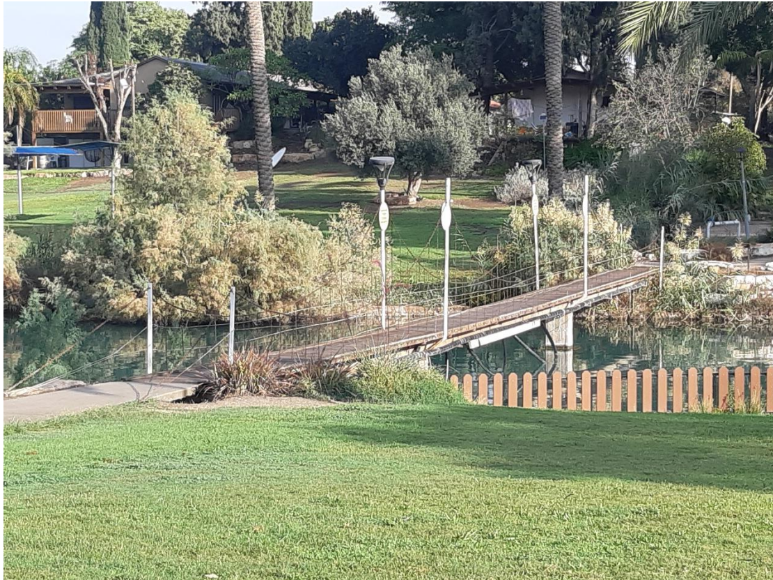
איור 13: גשר המעברה המערבי, לאחר שיפוצו, עם מעקה השרשראות והתקנת התאורה. (צילום: דרור סגל)
